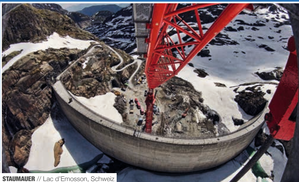
STAUMAUER // Lac d'Emosson, Schweiz
